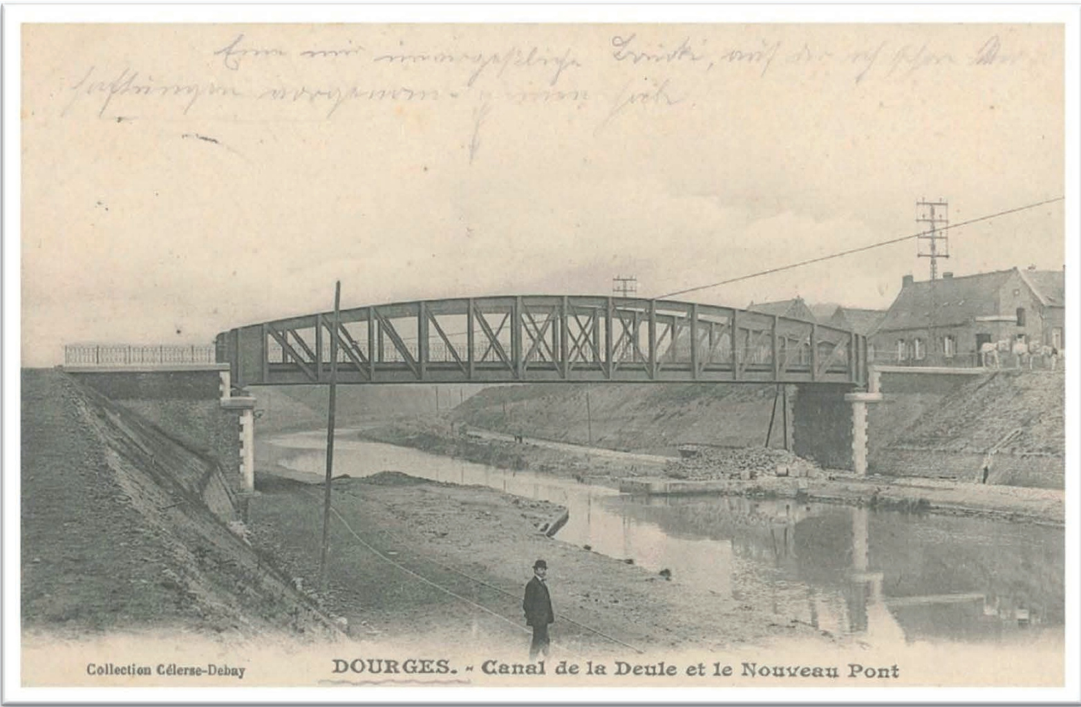
1904 – 1918, le pont de fer
