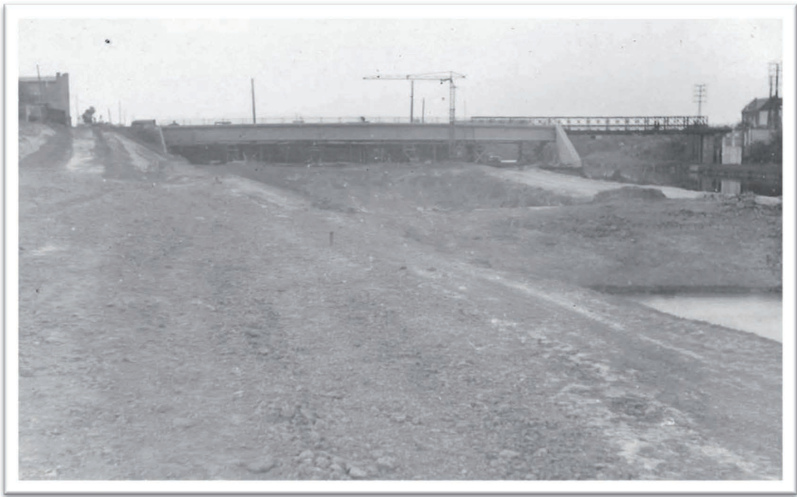
Construction du pont actuel en 1961. On aperçoit à droite le pont «Bailey » (1946-1961)
