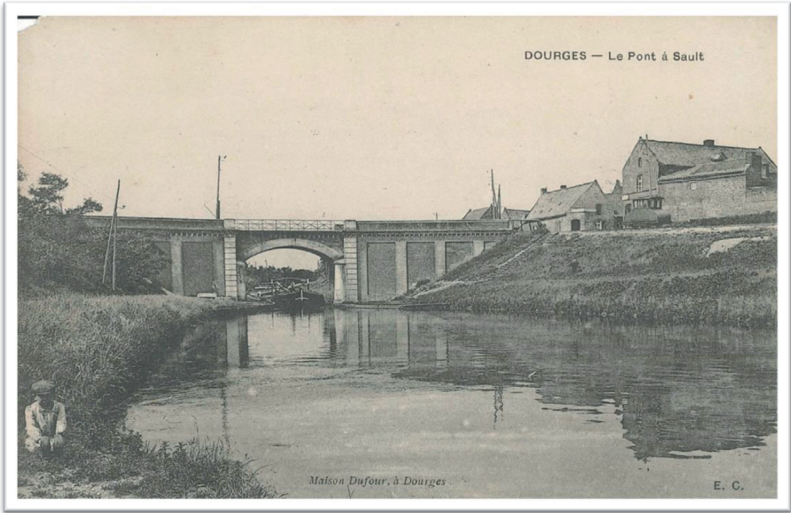
1858 – 1904, le pont de briques
