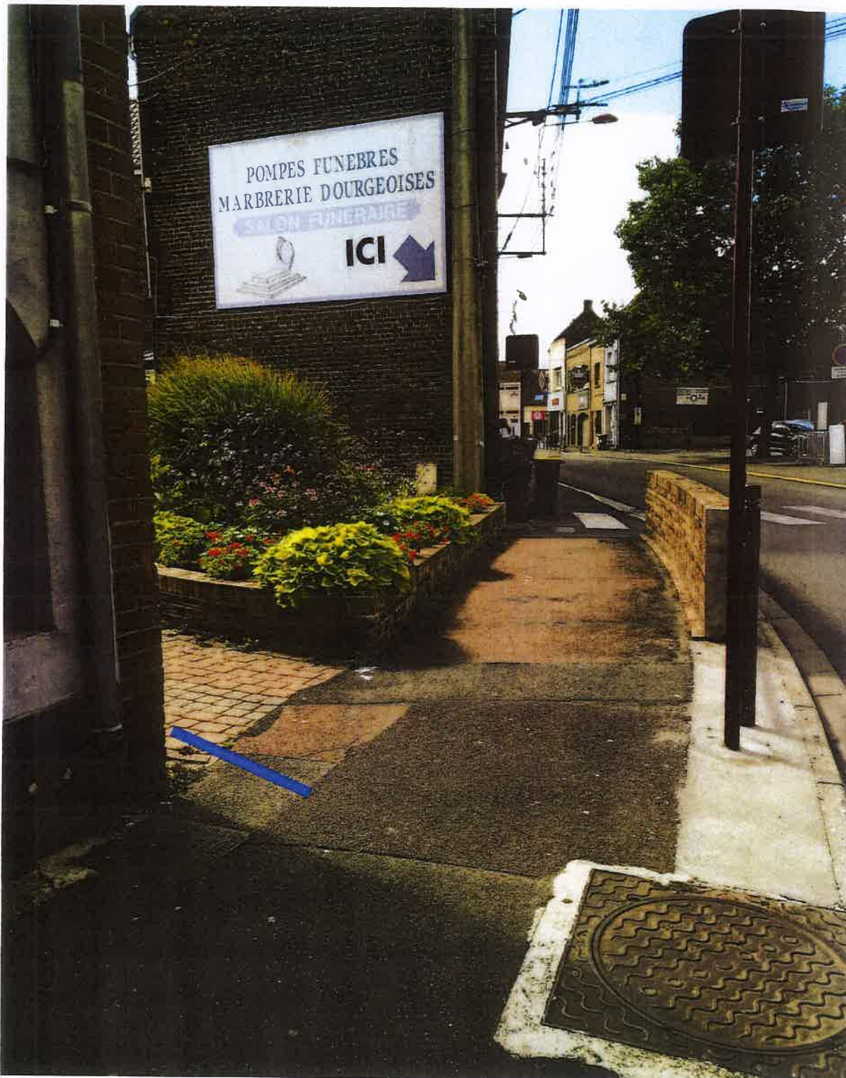
Installation échafaudage avec empiétement sur trottoir rue de la Liberté
